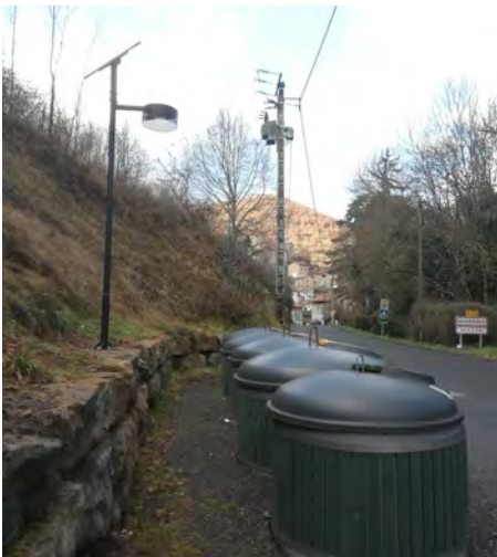
Réalisation d'un réverbère solaire pour le point poubelle de Verrières
