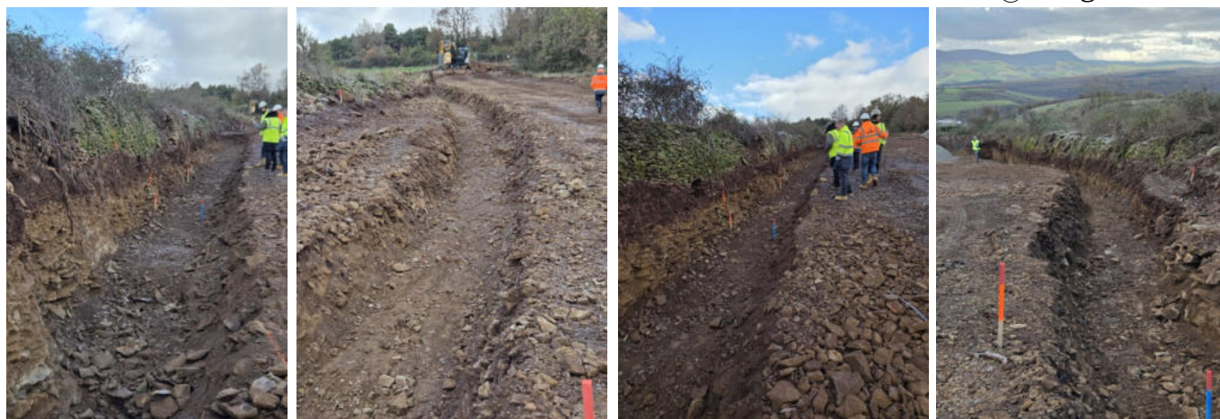
Travaux de construction de la tranchée drainante et infiltrante.
